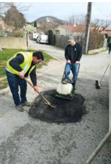
Réfections des chaussées endommagées
