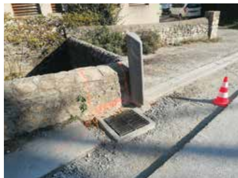
Nouvelle bouche d'eaux pluviales
