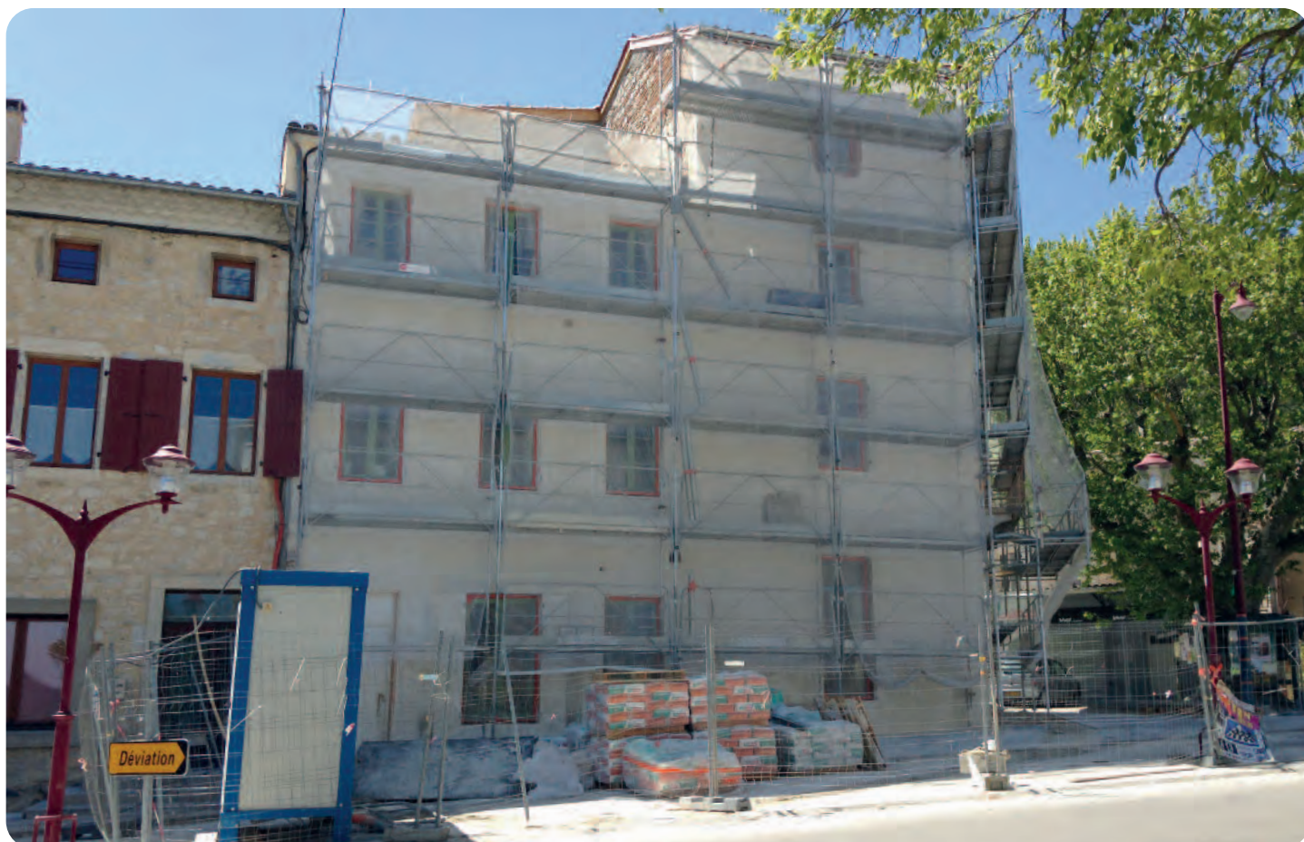
Avancement des travaux de l'immeuble Rey.
